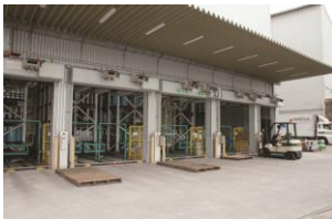
危険物自動倉庫
