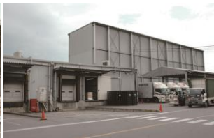
冷蔵自動倉庫
